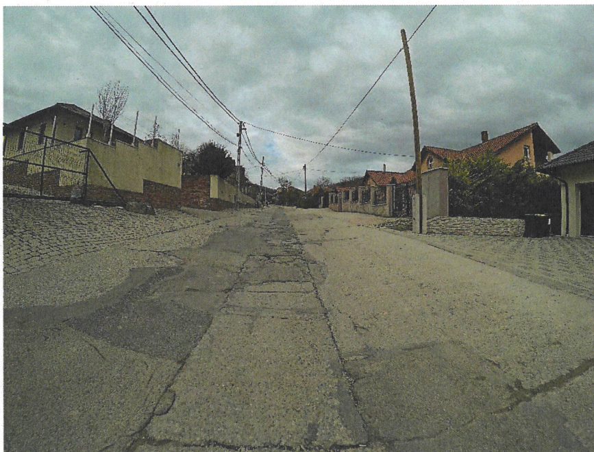
9. ábra: Meglévő állapot – Kerékhegy utca (Kápolna tér és a Hosszúvölgy utca közötti szakasz) – 1.
