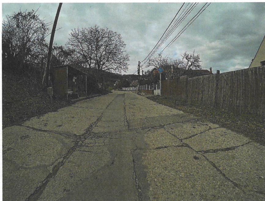
10. ábra: Meglévő állapot – Kerékhegy utca (Kápolna tér és a Hosszúvölgy utca közötti szakasz) – 2.
